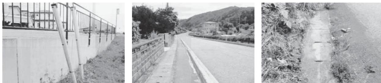
再生骨材を粗骨材として、高炉セメントB種を用いたプレキャストコンクリート製品を試作して山形県の3ヶ所で暴露試験を行っている。調査の結果、約6年経過後の製品は、それぞれ、凍害や塩害による被害状況はなく、普通コンクリート製品と同等の性能を有していることが分かった。
